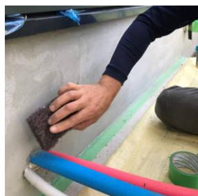
下地清掃 凹凸確認
