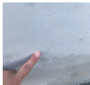
下地清掃・凹凸確認
